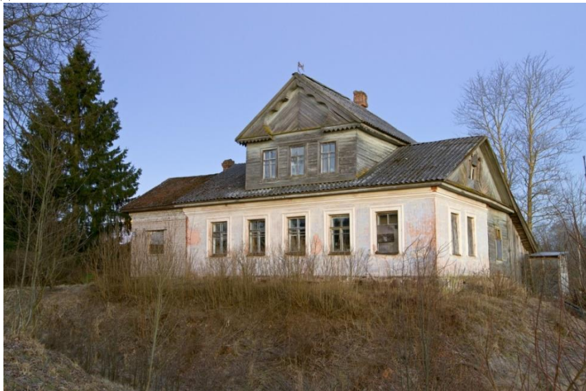
Рис. Здание музея
