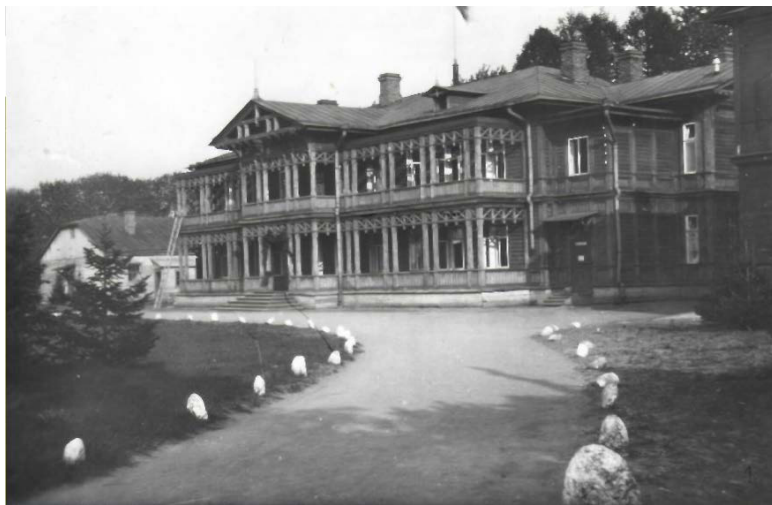
Рис. 1. Фотография (копия). Здание школы Е. С. Левицкой в Царском Селе [6]
