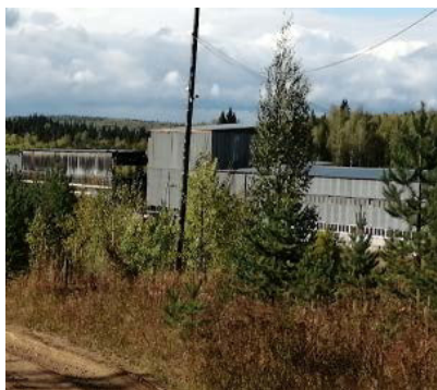
Рис. 5. Производственные помещения, между которыми расположена СГ-4
