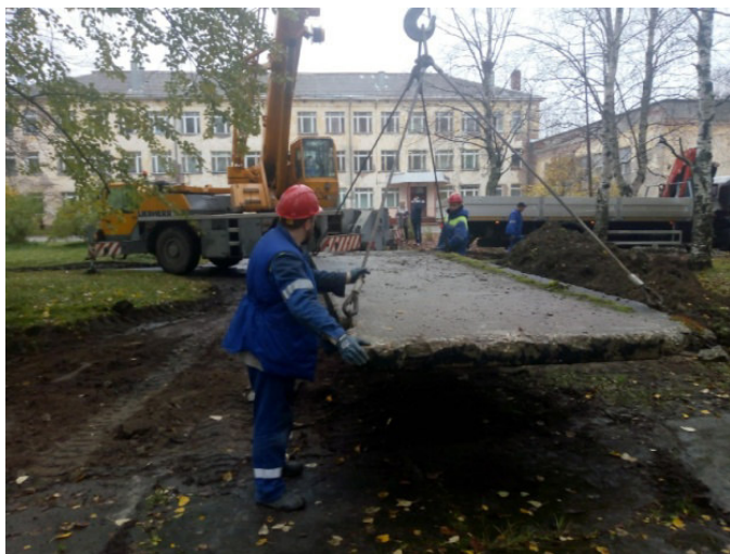
Рис. 1. Работа по благоустройству территории сквера
