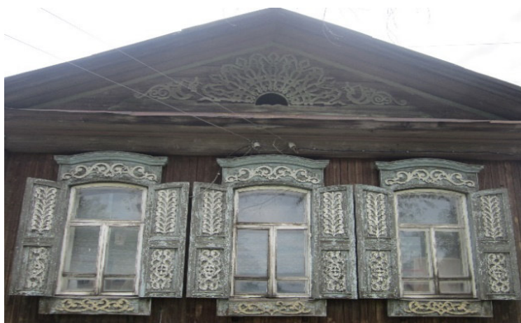
Рис. 2. Дом торговца П. А. Кичигина по ул. Ленина (Рыночная, Тестова), 44. Начало XX в. Растительный и геометрический орнамент. Накладная пропильная резьба. Фото автора
